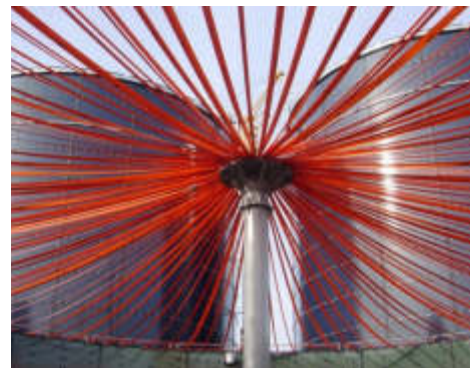
Edelstahlmittelstütze und Gurtunterkonstruktion
