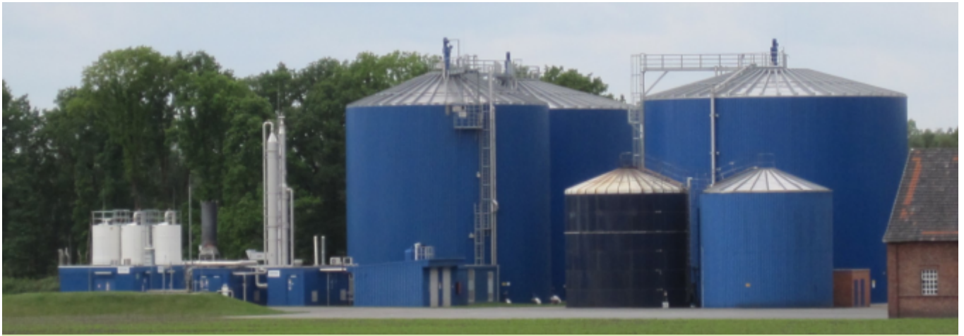
Biogas seit über 40 Jahren: Biogasanlage Wenning, 46414 Rhede The Wenning biogas plant in 46414 Rhede has been producing biogas for more than 40 years
