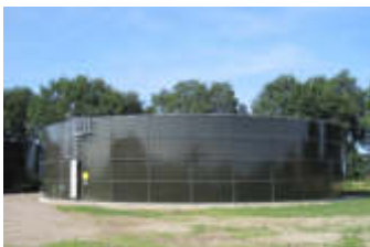
Güllesilo Slurry silos
